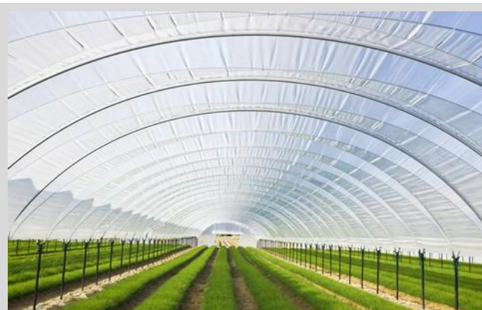
12/2016: Xây dựng hệ thống nhà màng cho 2ha đất sản xuất
